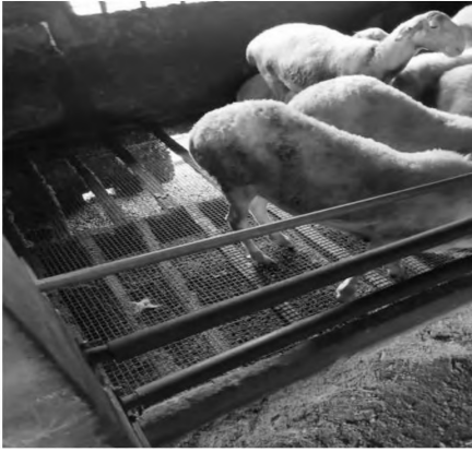
图2 防腐方格网架空层
